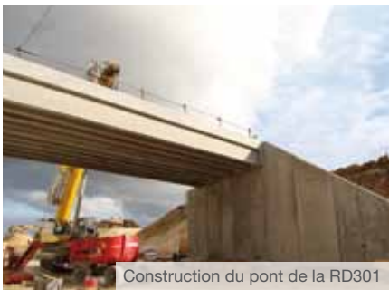
Construction du pont de la RD301
